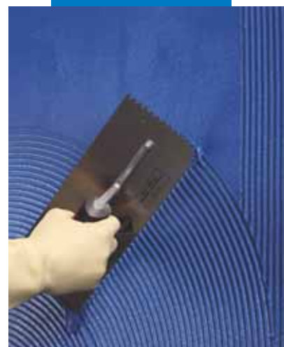
Applicazione con spatola dentata di Kerapoxy Design nel colore blu utilizzato come adesivo
