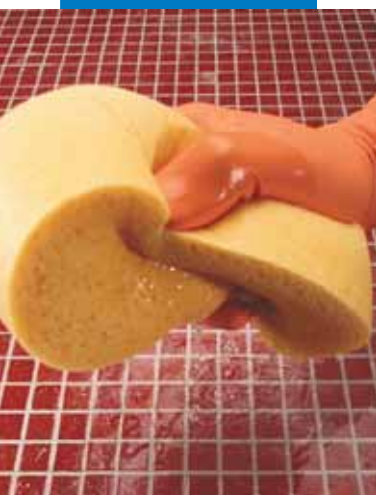
Bagnatura della superficie stuccata prima della pulizia
