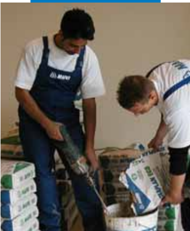
Miscelazione di Ultraplano Eco - Asilo Mirabello di Cantù - Italia
