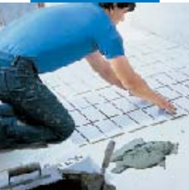
Terrazzo impermeabilizzato con Aquaflex e rivestito con ceramica
