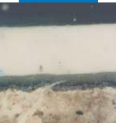
Risulta evidente sia la penetrazione del primer nella lastra di cemento amianto, sia l'efficienza dell'incapsulamento delle fibre di amianto garantita già dal primer
