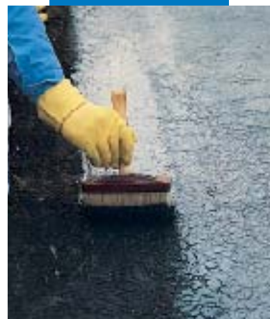
Applicazione di Aquaflex su vecchia membrana asfaltica
