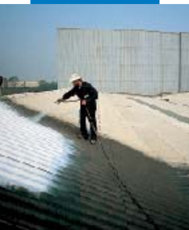
Applicazione di Aquaflex a spruzzo su cemento amianto ondulato trattato con Primer per Aquaflex
