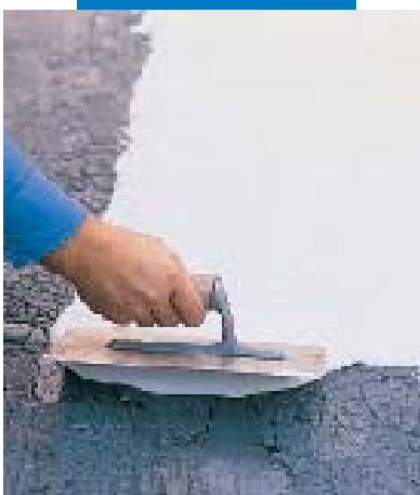
Successiva applicazione a spatola di Aquaflex
