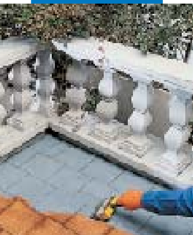
Applicazione di Primer per Aquaflex
