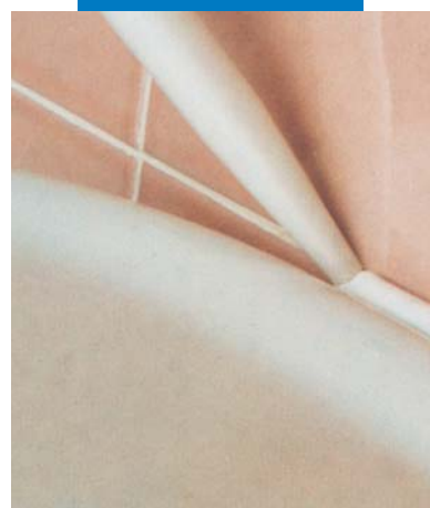
Sigillatura di sanitari
