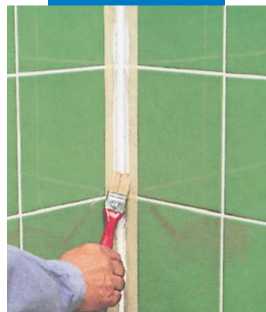
Lisciatura del giunto con acqua saponata a pennello
