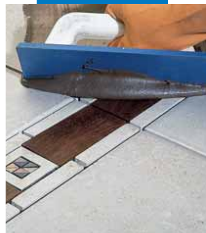
Stuccatura, con spatola, di pavimento ceramico con inserti in legno
