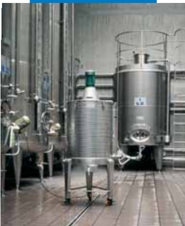
Esempio di stuccatura in cantina vinicola
