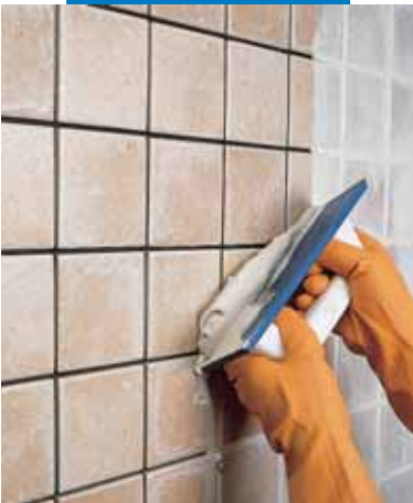
Stuccatura di rivestimento in monocottura con spatola
