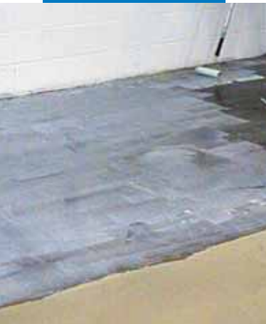
Applicazione di Mapeprim SP
