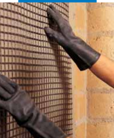
Posizionamento di Mapegrid G 220
