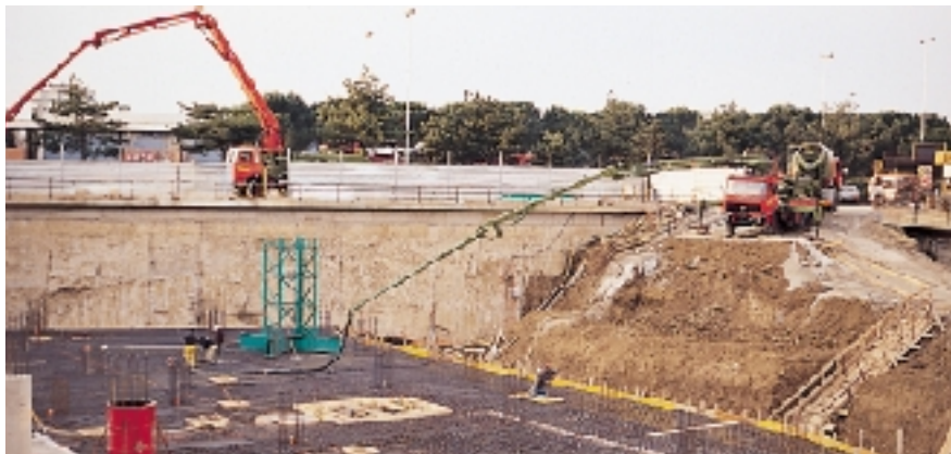
Getto di platea impermeabile con CIs additivato con MAPEFLUID PZ500
