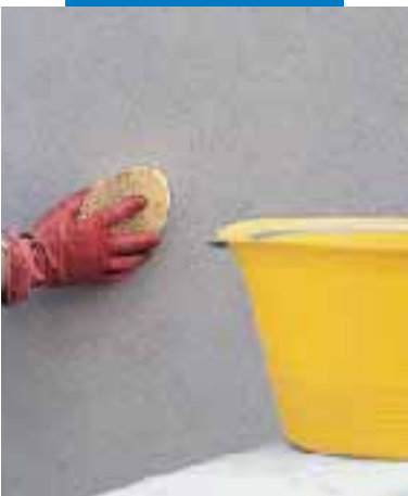
Rifinitura a spugna del Mape-Antique FC
