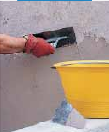
Applicazione a spatola di Mape-Antique FC
