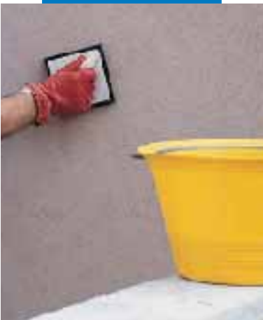
Rifinitura a frattazzo non appena Mape-Antique FC o Mape-Antique FC/R comincia a fare presa.
