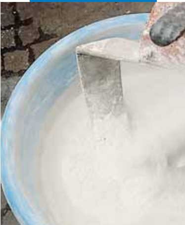
Preparazione dell'impasto di Mape-Antique MC
