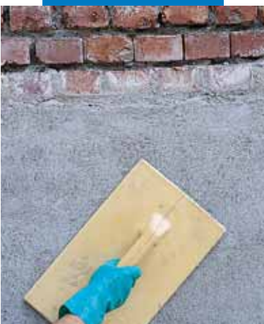
Rifinitura a frattazzo dell'intonaco eseguito con Mape-Antique MC
