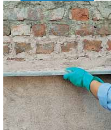
Livellamento dell'intonaco con Mape-Antique MC con staggia
