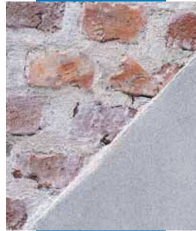
Particolare della sigillatura dei giunti e dell'intonaco realizzati con Mape-Antique MC
