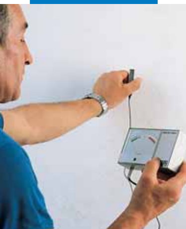
Controllo di umidità del gesso
