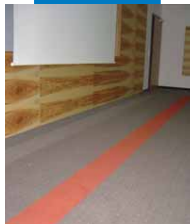
Esempio di utilizzo di Primer G prima della stesura di Ultraplan Eco e dell'adesivo Rollcoll per l'incollaggio della moquette nelle stanze dell'albergo - Villa Hotel Castellani - Austria
