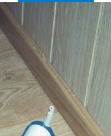
Zoccolino in legno applicato con Ultrabond Eco 575
