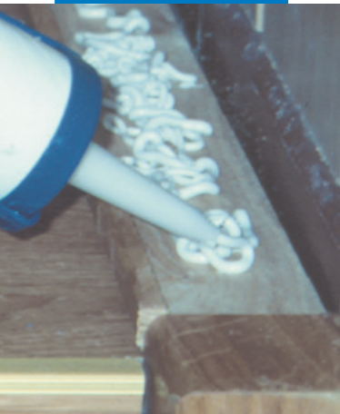
Incollaggio di zoccolino in legno con Ultrabond Eco 575
