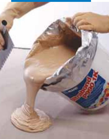
Versamento del collante sul massetto
