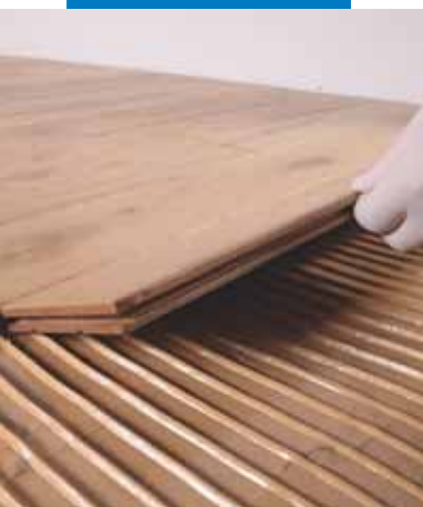
Posa del parquet
