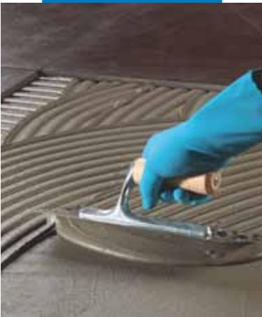
Stesura di **Keraflex Easy** sul supporto con spatola con dente arrotondato
