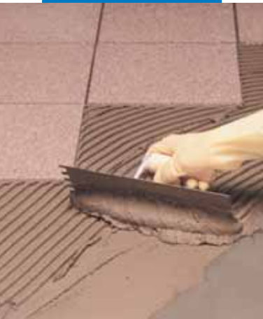
Esempio di posa di gres porcellanato su Mapelastik con Ultraflex S2 Quick
