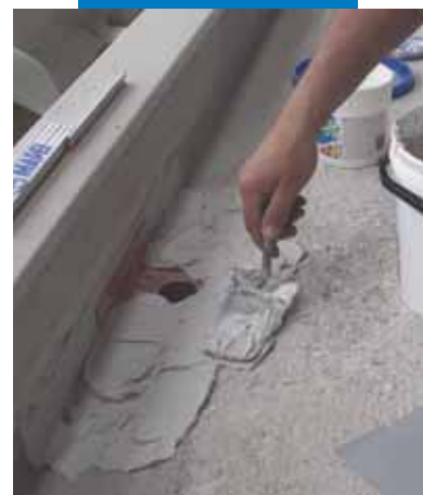
Rasatura successiva con Adesilex PG4
