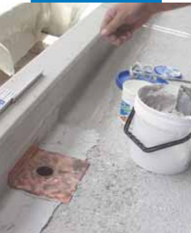
Posa di collarino e relativa piletta in rame
