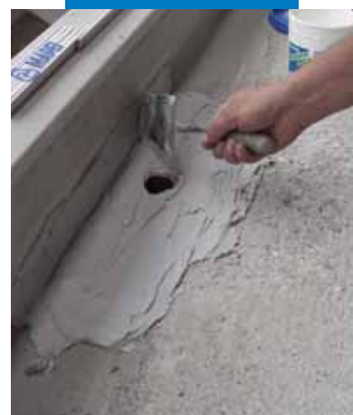
Copertura finale con Adesilex PG4
