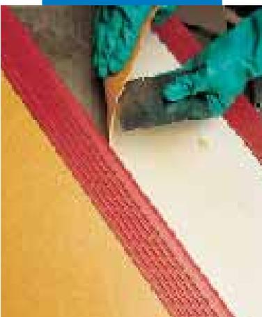
Stesura di Adesilex VZ sul rovescio del rivestimento in PVC
